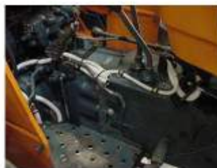
Fig. 13 - stessa trattore dove è stato installato micro interruttore sulla frizione - se durante l'avviamento il pedale della frizione non è abbassato la macchina non parte
