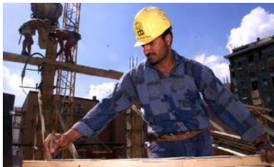
Un operaio al lavoro in un cantiere
