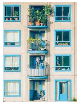
Condominio. Detrazione al 110%
