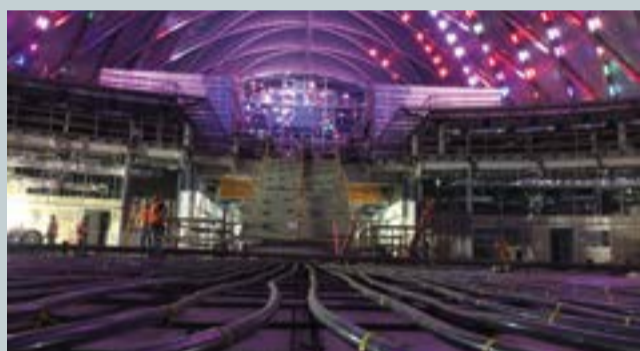
Figura 4. A sinistra: L'ARTIC con il sistema di riscaldamento radiante installato, prima della posa della pavimentazione; a destra: risultato finale dell'interno di ARTIC
