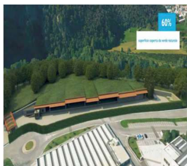
Depuratore di Valtrompia
